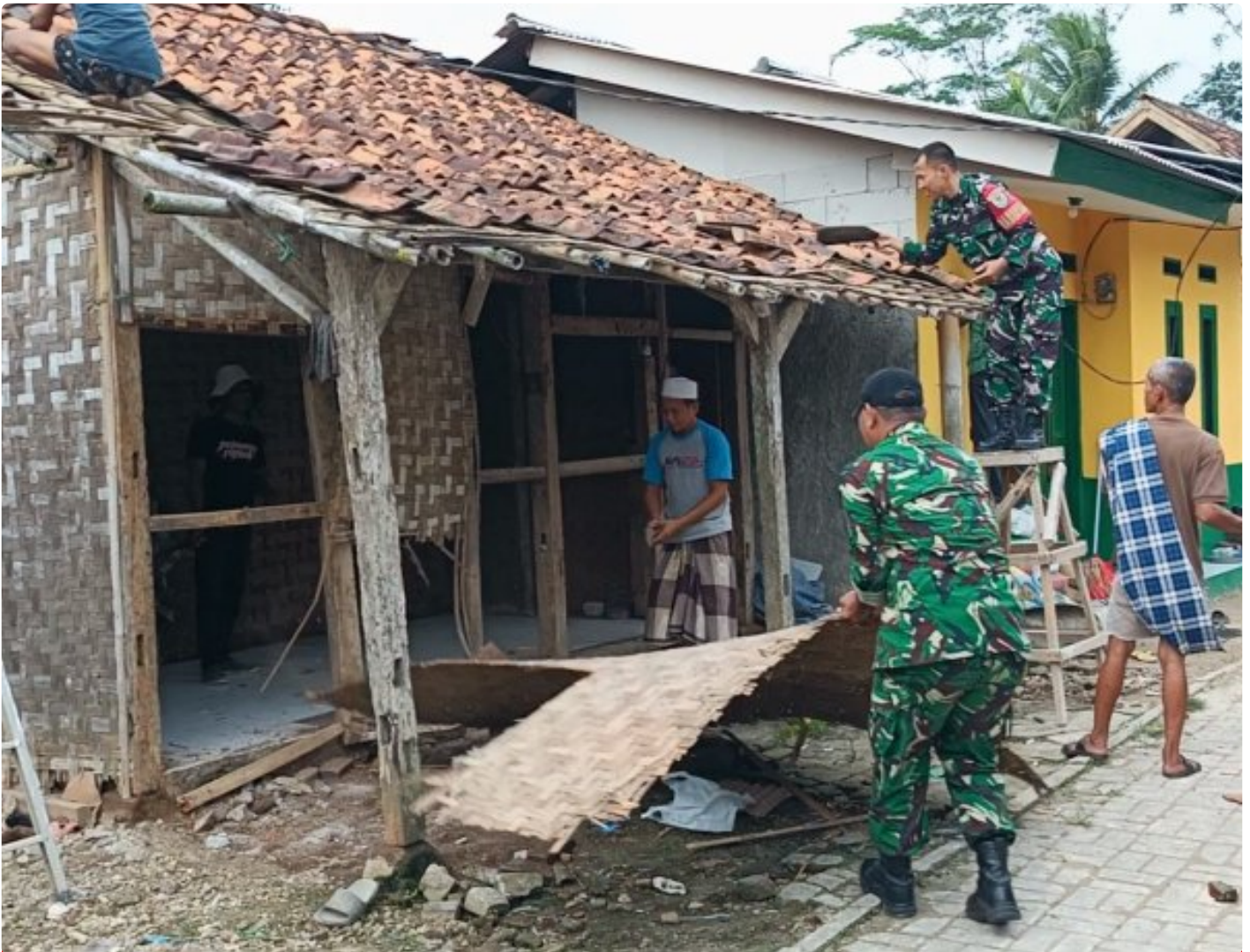
Pembongkaran Rumah Bapak Narmin
